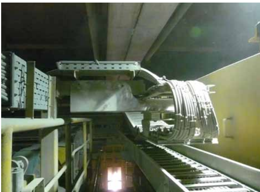
Bild FA2212-02: Igus GmbH, Köln Einfache Anbindung: Als Aufnahmen für die Energiekette konnten die vorhandenen Komponenten verwendet werden.
