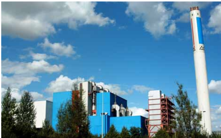
Bild FA2212-01: Müllverbrennungsanlage Weisweiler GmbH & Co. KG Die MVA Weisweiler bei Aachen ist eine der modernsten Müllverbrennungsanlagen Deutschlands.
