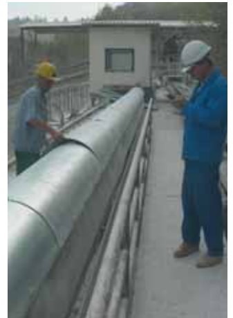
Czech Republik. Lhoist a.s. BBP (Building block principle) steel construction for spreader in lime plant. Tschechien. Lhoist a.s. Baukastenprinzip-Stahlkonstruktion in Kalkwerk.
