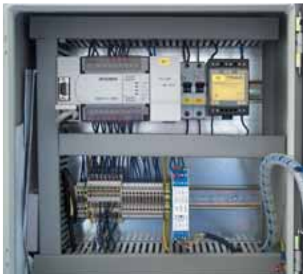
PPDS. Can be called up by e-mail or SMS for monitoring of system health. PPDS. Zur Überwachung der zulässigen Zug- und Schubkräfte weltweit per E-Mail oder SMS abrufbar.
