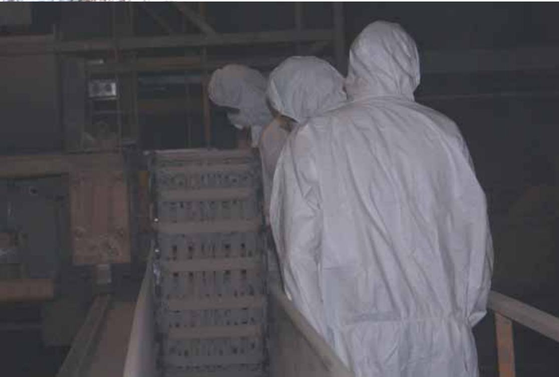
Inspection of an E-Chain® in a refuse incineration plant Inspektion einer E-Kette® in einer Müllverbrennungsanlage
